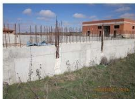
F-03 Tanque Biocos: losa 100% y alzados 50 %
