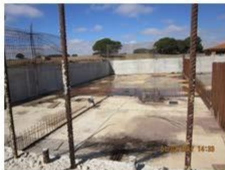
F-03 Tanque Biocos: losa 100% y alzados 50 %
